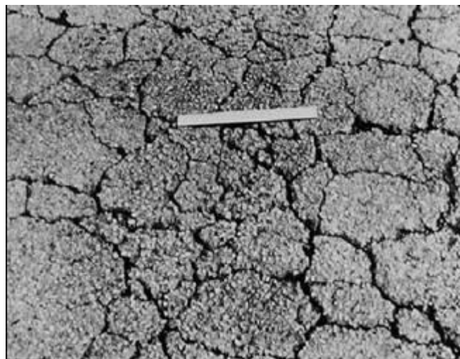
Fig. X1.3 Piel de Cocodrilo – Alta Severidad
