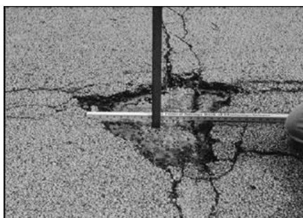
Fig. X1.36 Bache – Mediana Severidad
