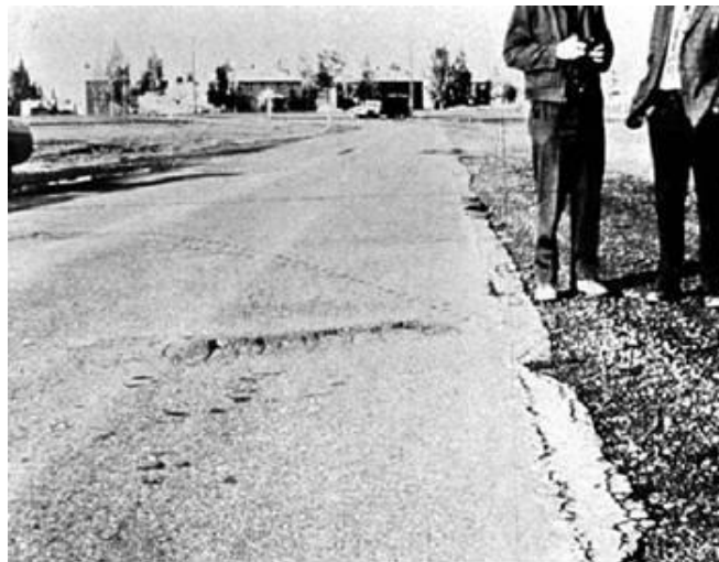
Fig. X1.11 Abultamientos y Hundimientos – Mediana Severidad
