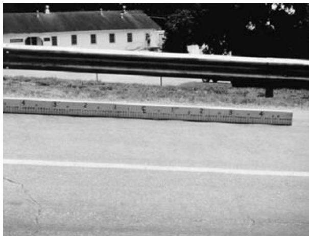
Fig. X1.13 Corrugación – Baja Severidad
