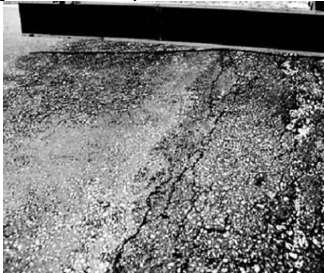
Fig. X1.11 Abultamientos y Hundimientos – Mediana Severidad
