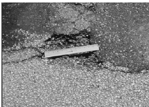
Fig. X1.35 Bache – Baja Severidad
