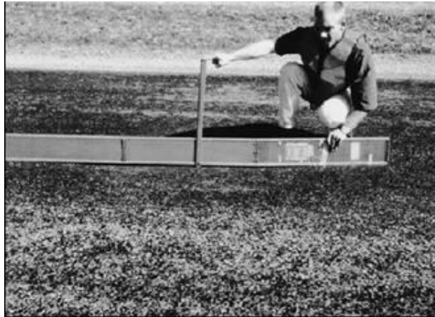
Fig. X1.16 Depresión – Baja Severidad
