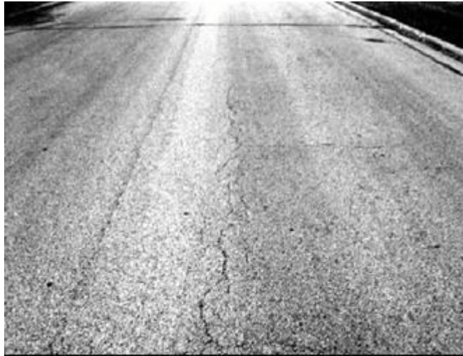
Fig. X1.1 Piel de Cocodrilo – Baja Severidad
