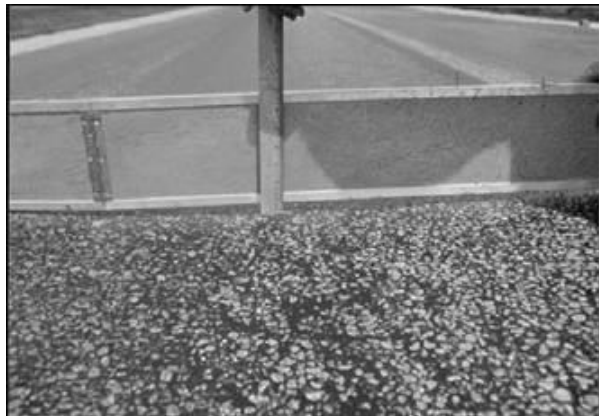
Fig. X1.42 Ahuellamiento – Mediana Severidad
