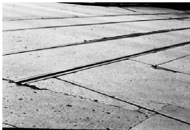
Fig. X2.38 Cruce de Vía Férrea – Baja Severidad
