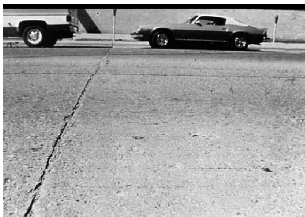
Fig. X2.48 Descascaramiento de Junta – Baja Severidad
