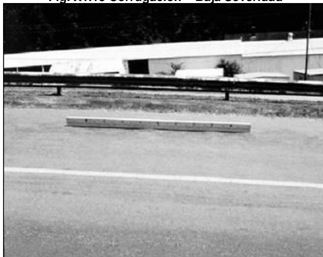
Fig. X1.13 Corrugación – Baja Severidad
