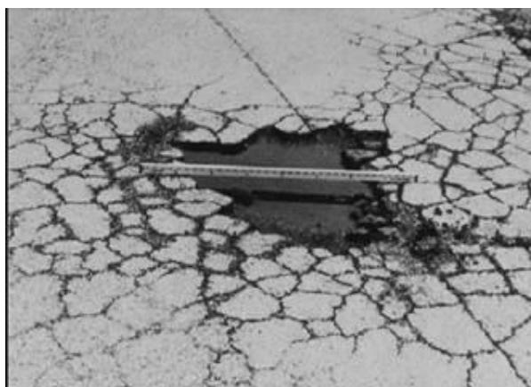
Fig. X1.37 Bache – Alta Severidad
