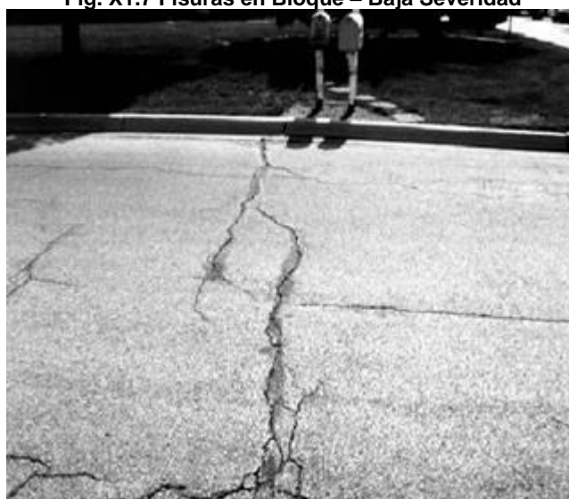
Fig. X1.7 Fisuras en Bloque – Baja Severidad
