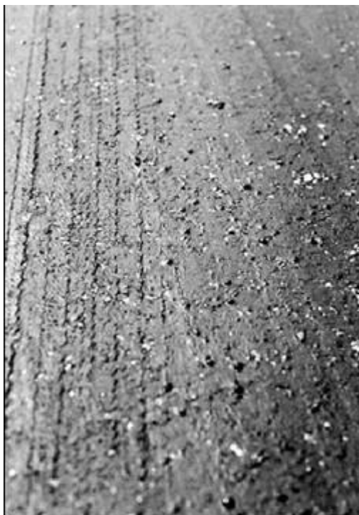
Fig. X1.6 Exudación – Alta Severidad
