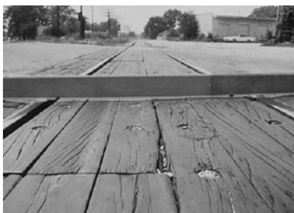
Fig. X1.38 Cruce de Vía Férrea – Baja Severidad
