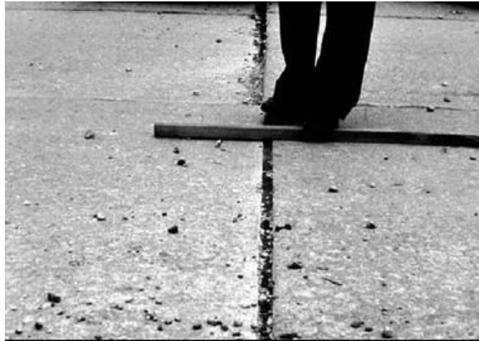
Fig. X2.13 Escalonamiento – Baja Severidad
