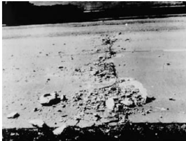
Fig. X2.2 Levantamiento/Pandeo – Mediana Severidad
