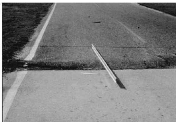
Fig. X1.46 Desplazamiento – Alta Severidad
