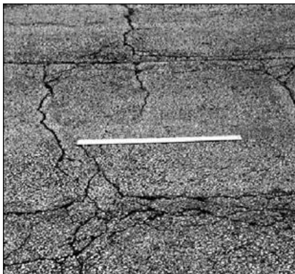
Fig. X1.7 Fisuras en Bloque – Baja Severidad
